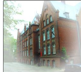
Zdjęcie 1 - Budynek Katedry Mikrobiologii AMG
